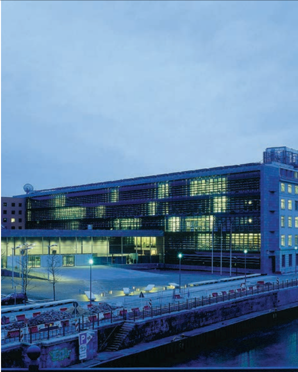
Außenansicht Klimafassade Foto: Stefan Klönk, Berlin
