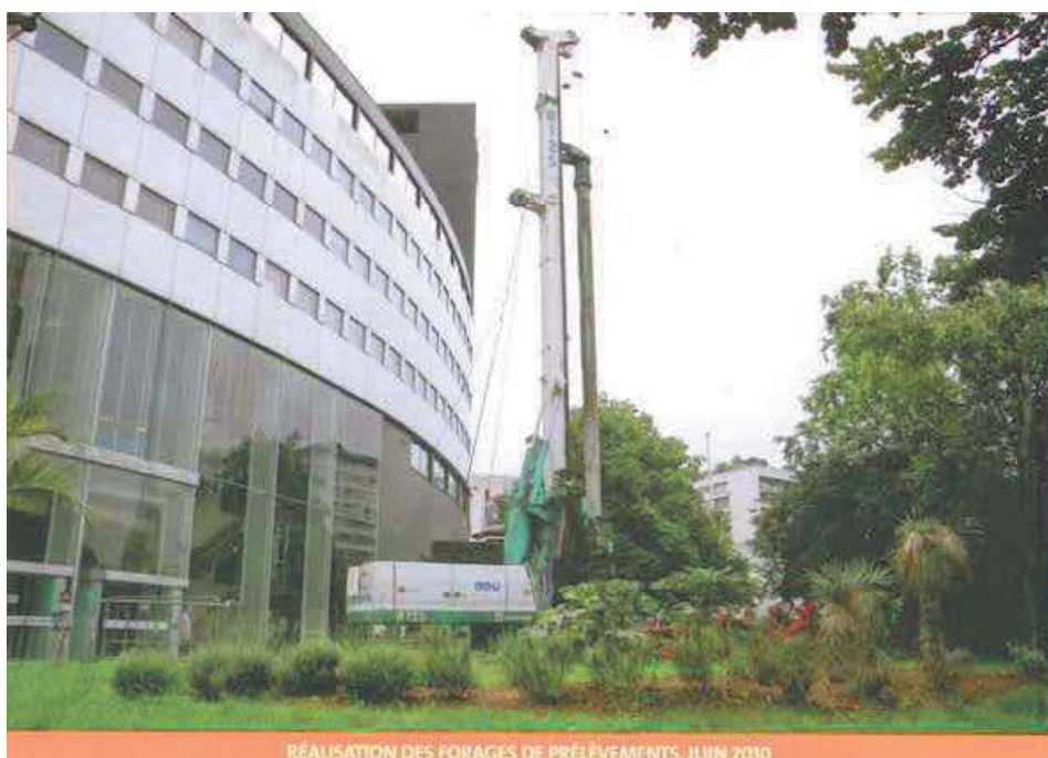
RÉALISATION DES FORAGES DE PRÉLÈVEMENTS, JUIN 2010
